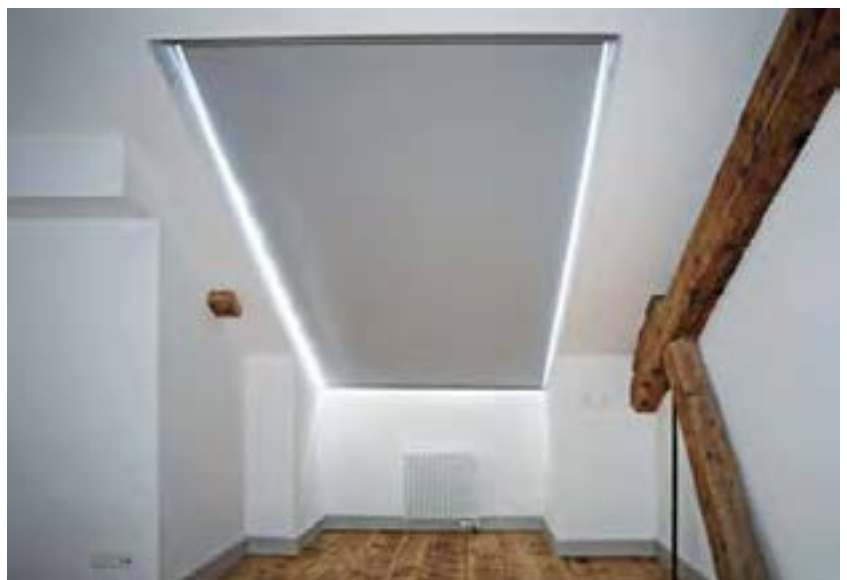
Dachfenster s:203 ergänzt mit einer äusseren wie auch einer innen liegenden Beschattung.
