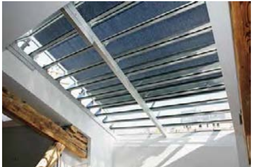
Dachfenster s:203 ergänzt mit einer äusseren wie auch einer innen liegenden Beschattung.
