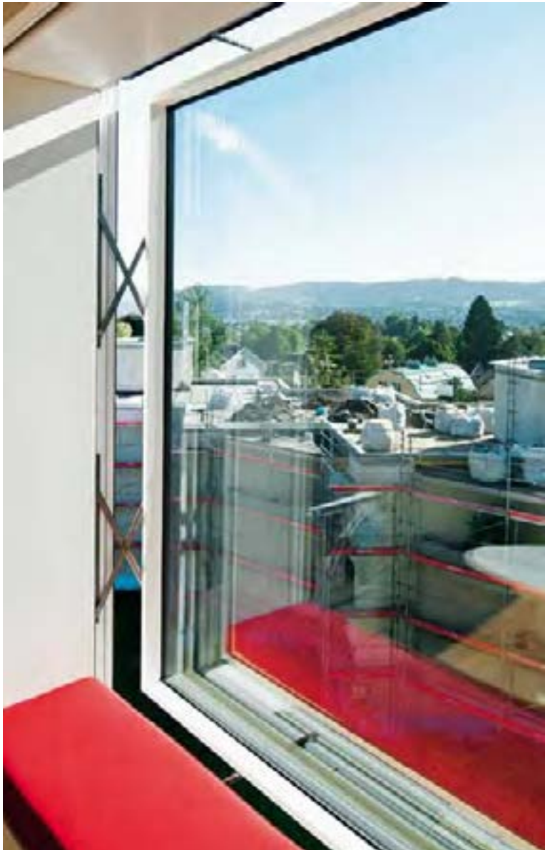
Das Parallelausstellfenster kann stufenweise geöffnet werden und ist dadurch besonders sicher.
