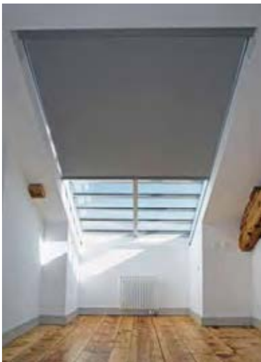
Dachfenster s:203 ergänzt mit einer äusseren wie auch einer innen liegenden Beschattung.
