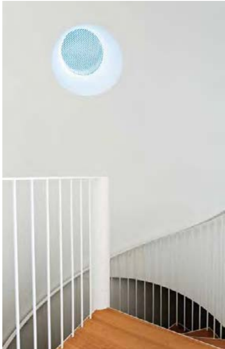
Klappfenster mit Lochblech-Sonnenschutz und ästhetischem Blendschutz.
